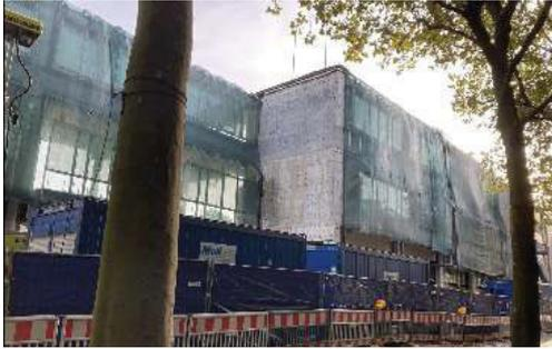
Staubbindung durch Netze an der Gebäudehalle
