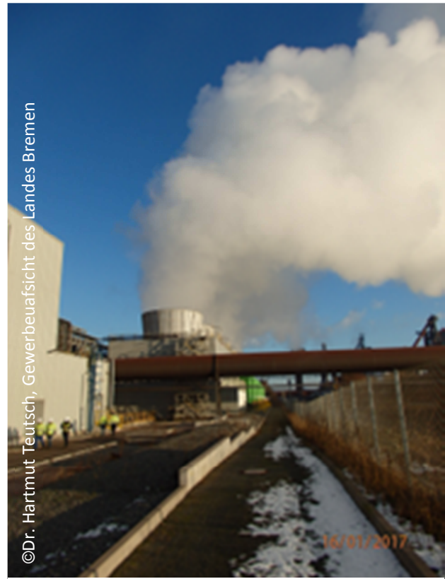
Abb. 2a: Großes Rückkühlwerk als Verdunstungskühler
