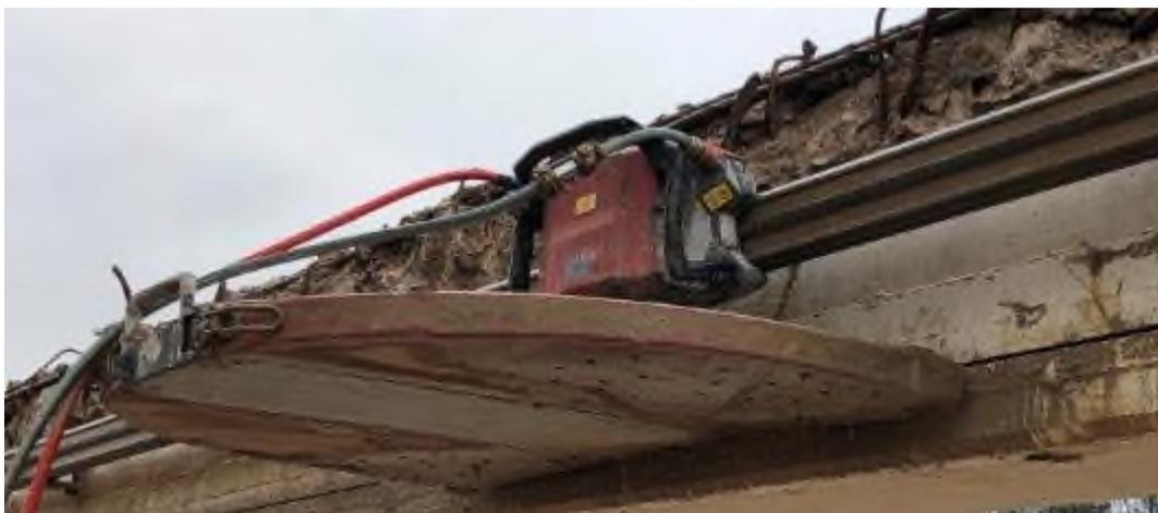
Bild 1 Betonsäge im Einschnitt (Quelle: Bauherr)
